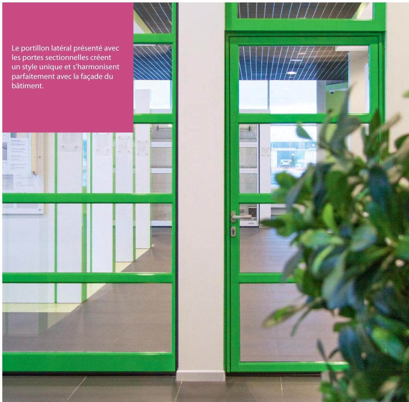
Le bâti dormant et l'encadrement des portes sont en profils d'aluminium extrudé.
